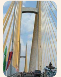
メコン経済圏の南部経済回廊の要衝となる「つばさ橋」の建設に協力 (カンボジア)
